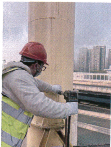
1 号天然气锅炉排气筒
